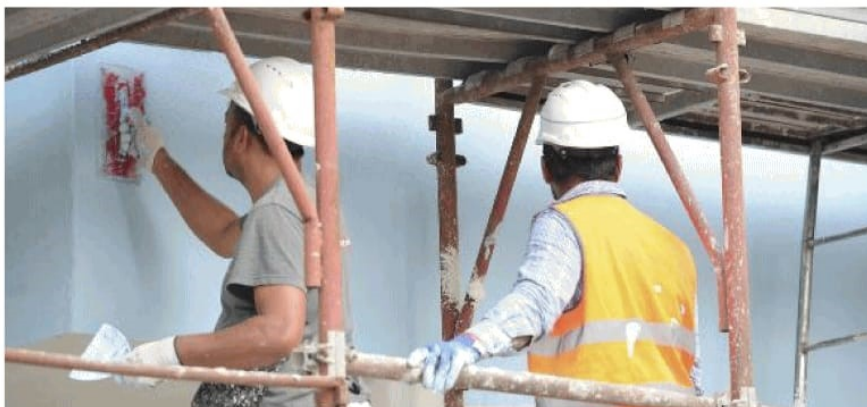
Un cantiere a Modena dove gli operai stanno ristrutturando la facciata di un palazzo
